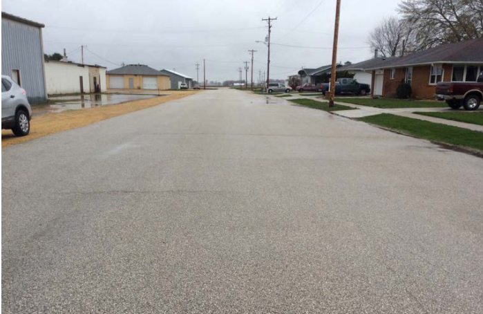
DEWITT STREET - SEGMENT 012 - HMA STREET - PCI=85
